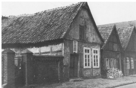
Häuser in der „Dreckstrate“, heute Bahnhofstraße © Heimatverein Liebenau
